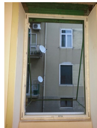
Posizionamento controtelaio
