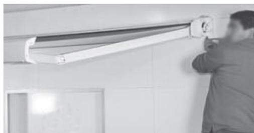
La tenda è predisposta in stabilimento per un'inclinazione di circa 30°; detta inclinazione risulta ottimale per le caratteristiche tecniche della tenda; se si desidera modificare l'inclinazione, si deve procedere come segue:
