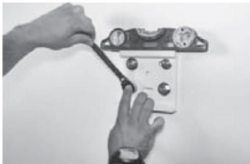
Inserire i blocchi e le viti per il fissaggio delle staffe
