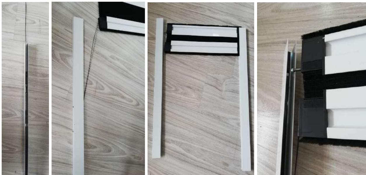
**Nota.** Posizionare la zanzariera lungo il vano luce ed avvitare i tasselli dove in precedenza sono stati effettuati i fori, facendo attenzione a non danneggiare o bloccare i tensionatori.
