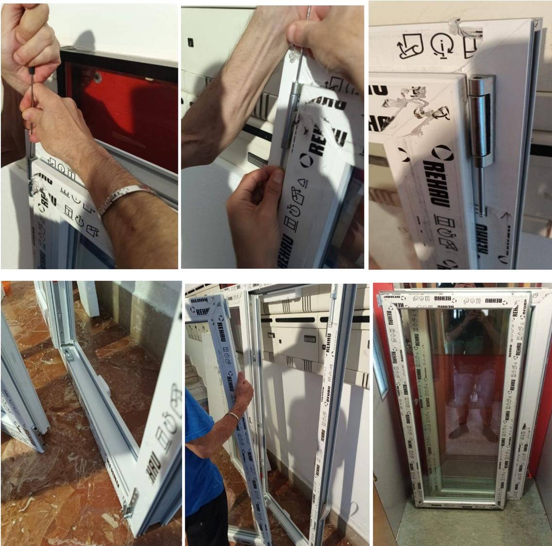
Le seguenti foto mostrano la situazione preesistente con i cardini delle cerniere del precedente infisso in legno che dovranno essere rimossi tramite un flex per predisporre l'installazione del nuovo controtelaio in appoggio al precedente ligneo.
