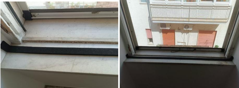
Il controtelaio dell'infisso prevede già i fori per l'inserimento delle apposite viti.
