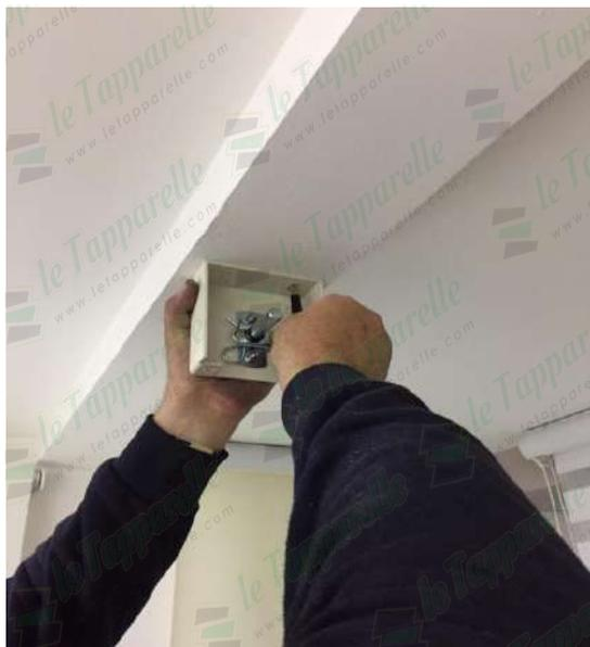
**6. CON L'AUSILIO DI UN TRAPANO PRATICARE I FORI IN CORRISPONDENZA DELLE DUE ASOLE E MONTARE LA SECONDA STAFFA**
